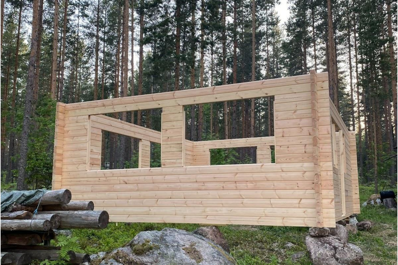
Mäntsikän uusi rillikatoksen kehikko työvaiheessa.
